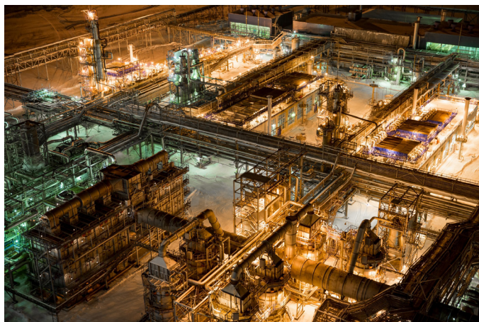
Комплекс по облагораживанию моторных топлив
